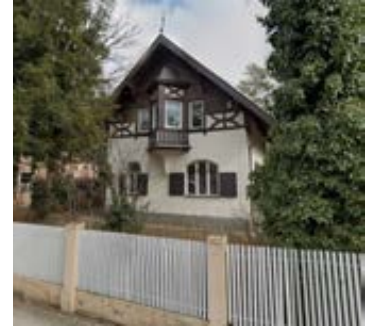
Vor der Renovierung
