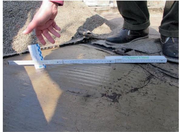
*Prall gefüllte Blase zwischen Beschichtung und Grundierung*
