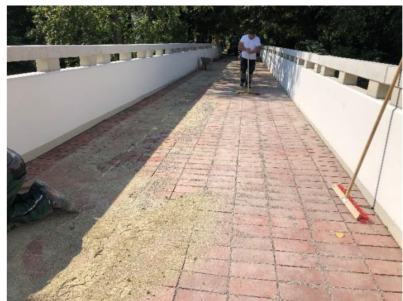
Verlegung des Pflasters unter Berücksichtigung des Gefälles
